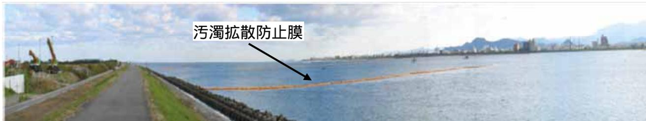
汚濁拡散防止膜の設置状況(阿波しらすぎ大橋)
