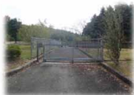
緊急開口部(約30箇所)
