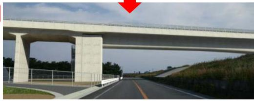
A1橋台背面を連続カルバート化や、橋台前面の角をサークルハンチとすることで、交差道路を通過するドライバーから見たコンクリート壁や盛土構造による圧迫感が軽減されたと考えられる。
