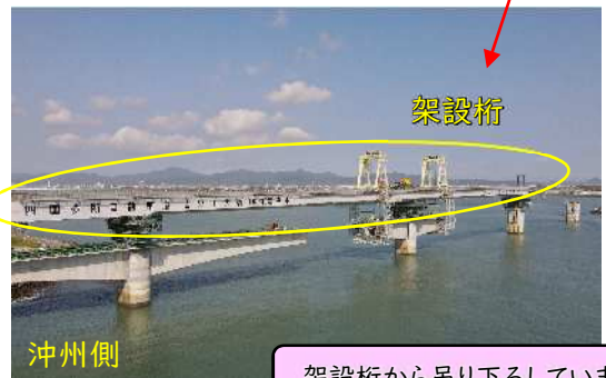
架設桁から吊り下ろしています
