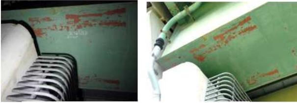
塗膜劣化 (左: 近接目視 右: ドローン)
