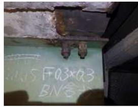
ボルト腐食 (左: 近接目視 右: ドローン)
