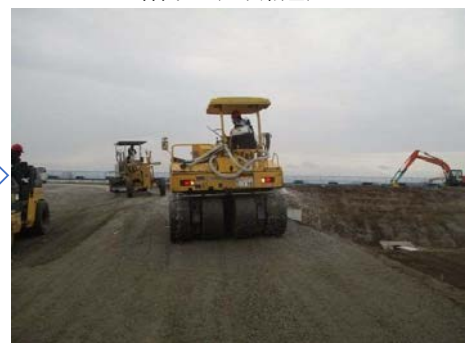
締固め（2次転圧）
