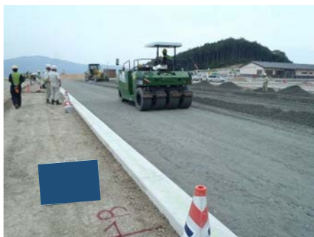
下層路盤やコンクリート舗装版の路盤として施工。
