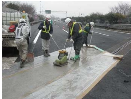
セメントミルクの振動・締固め
