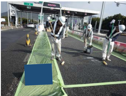
プライマー塗布
