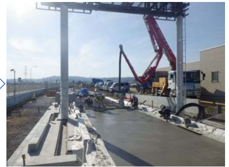
コンクリート打設
