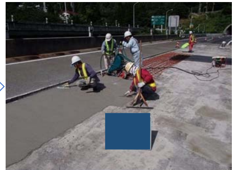
断面修復（コンクリート打設）
