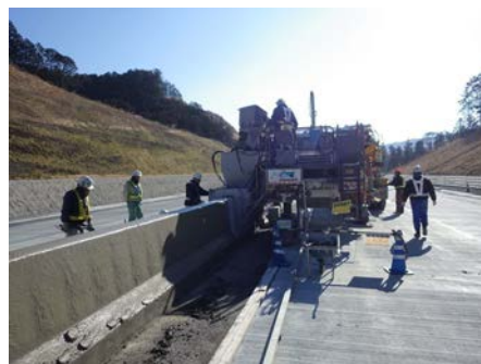
コンクリート打設
