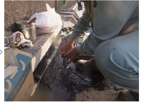
ドレーン設置
