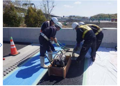
セメントミルク注入
