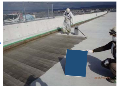
床版用接着材塗布
