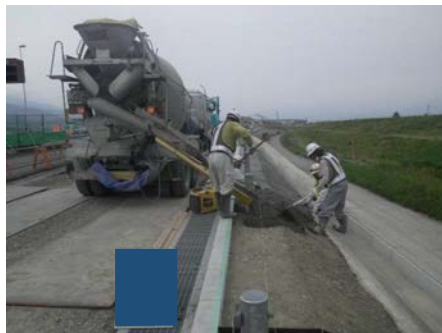
コンクリート打設
