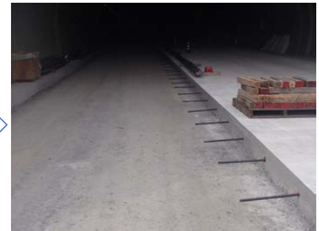
1車線分打設完了
