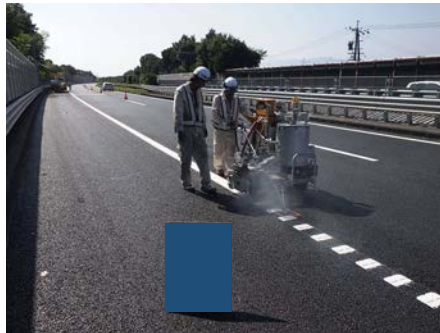
路面標示 (ライン) 施工
