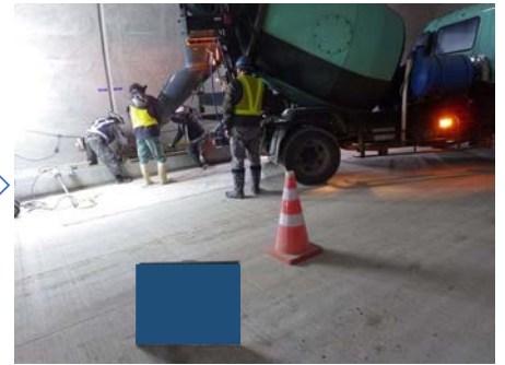
コンクリート打設
