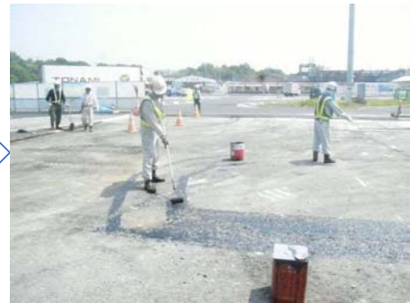
瀝青材散布工
