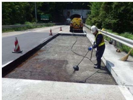
瀝青材散布工
