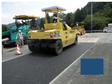
試験舗装(2次転圧)
