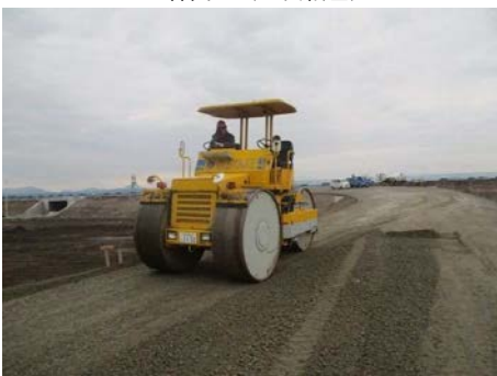
締固め（1次転圧）
