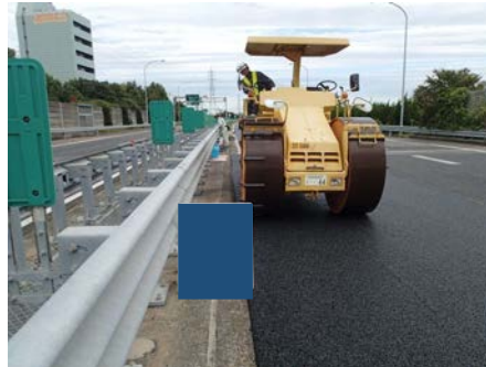
【転圧型】 鉄輪に型枠設置
