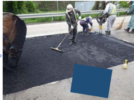
敷均し・締固め
