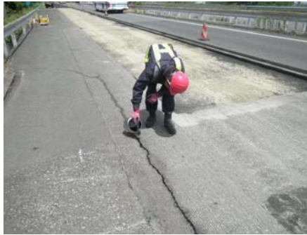
【瀝青材の注入】 注入作業
