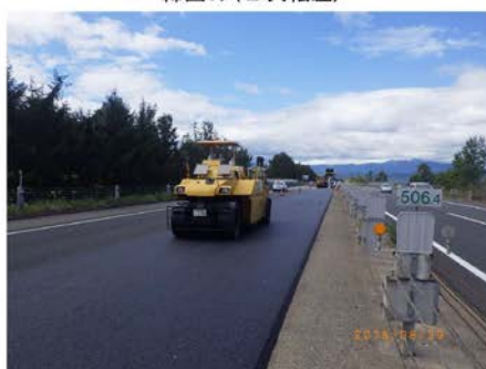
締固め (2次転圧)
