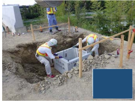
ハンドホール据付
