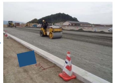
締固め(2次転圧)
