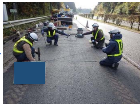
ループコイル埋設
