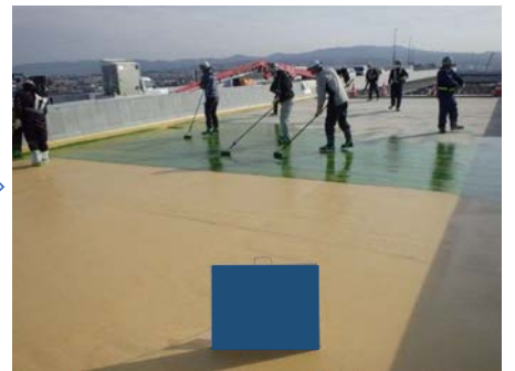
舗装用接着材塗布
