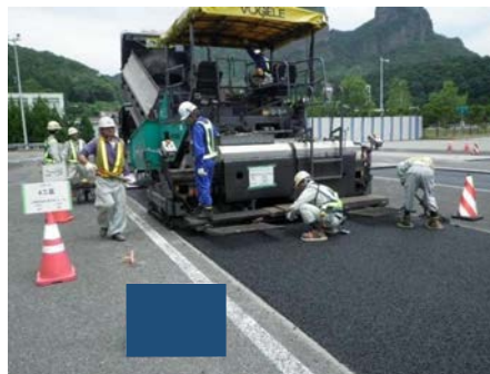
試験舗装(敷均し)
