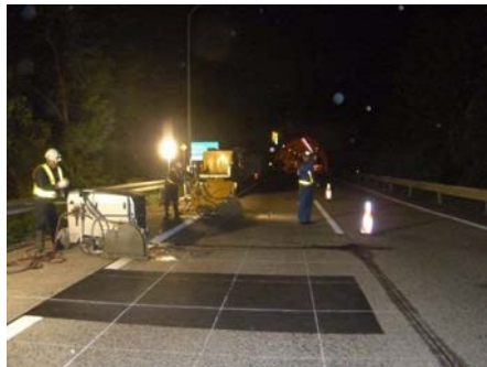
既設舗装の切断
