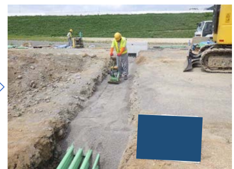
保護砂埋戻し・締固め
