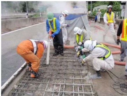
床版コンクリートはつり（ウォータージェット）
