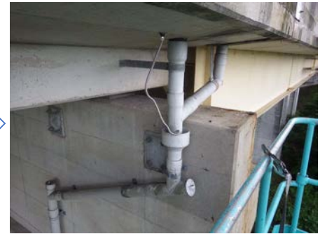
床版下面導水処理
