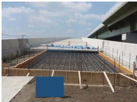
型枠設置・鉄筋工
