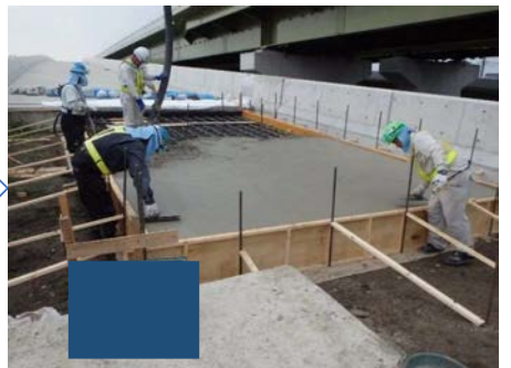
コンクリート打設
