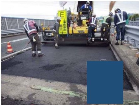
アスファルト混合物敷均し
