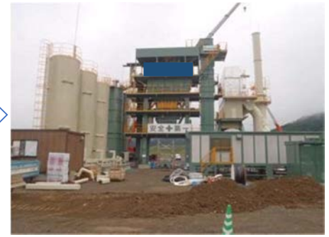
仮設完了(電気配線など)
