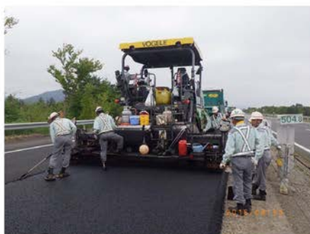
アスファルト混合物敷均し
