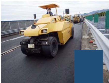
締固め（2次転圧）
