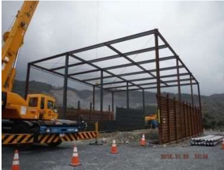
骨材仕切、上屋設置
