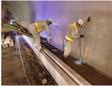
均しコンクリート打設
