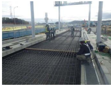
鉄網・補強鉄筋配置
