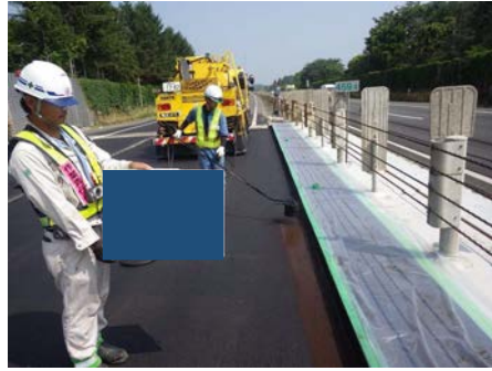
【アスファルト縁石工】 乳剤散布
