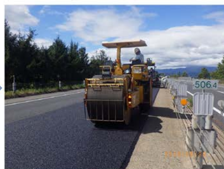
締固め (1次転圧)
