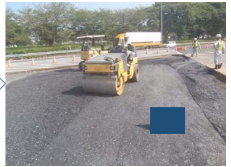
締固め(1次転圧)
