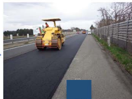
アスファルト混合物締固め
