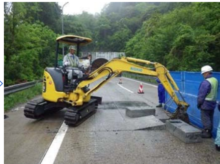
既設舗装の剥取り
