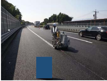
リブのみ施工
