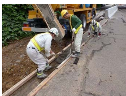
基礎コンクリート打設
