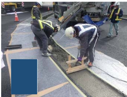
基礎コンクリート打設
