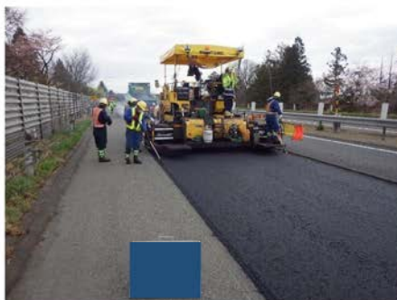
アスファルト混合物敷均し
