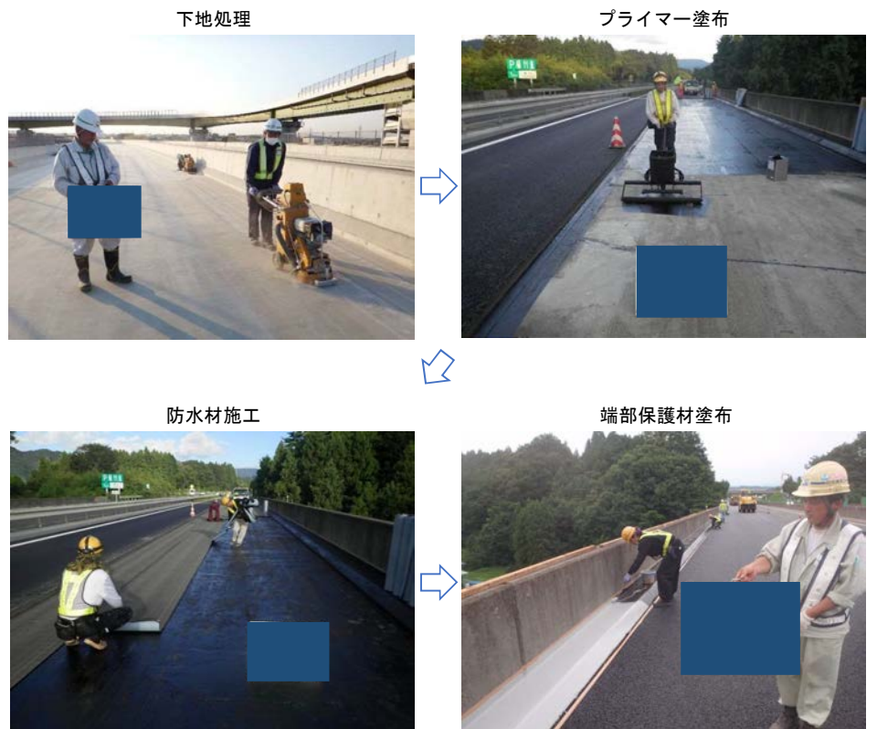
写真は、床版防水工（グレードⅠ）シート系防水の施工状況を示す。
