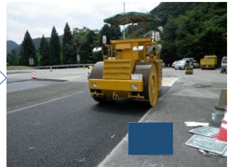
試験舗装(1次転圧)
