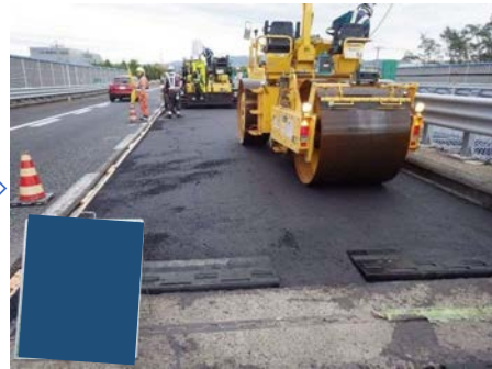
締固め（1次転圧）
