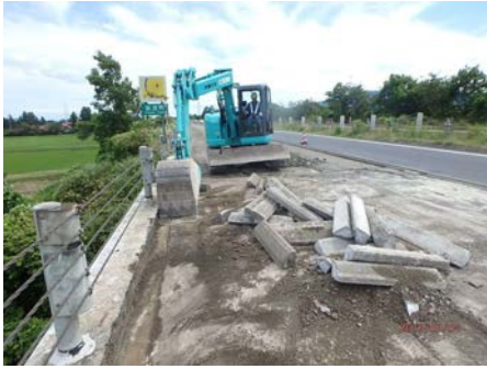
【縁石撤去】 縁石取壊し
