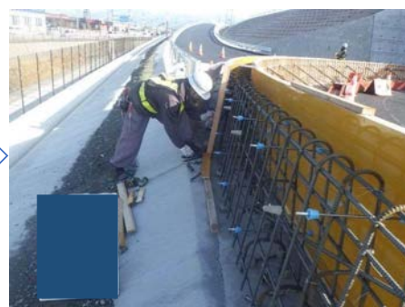
鉄筋工・型枠工
