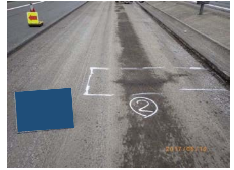
【シート材の貼付け】 施工前（ひび割れ状況）
