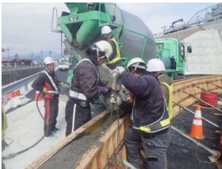
コンクリート打設
