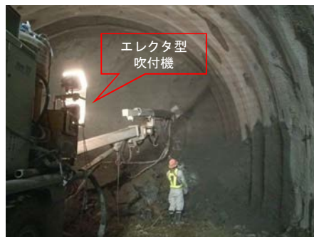
吹付コンクリート
