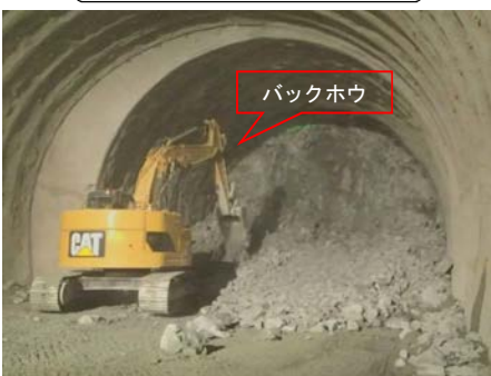
すり処理（すり積み）
