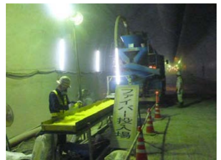
繊維現地混合 (覆工コンクリート)
