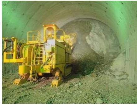
上半掘削 (トンネル掘進機)
