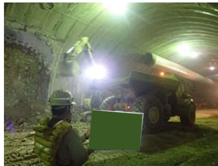
ずり処理 ( ずり積込み )
