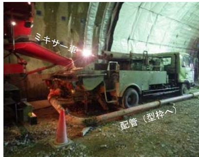
覆工コンクリート (打設)
