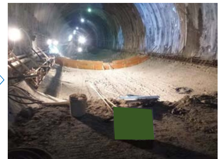
インバート型枠
