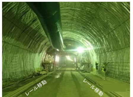
型枠移動 (養生完了後)
