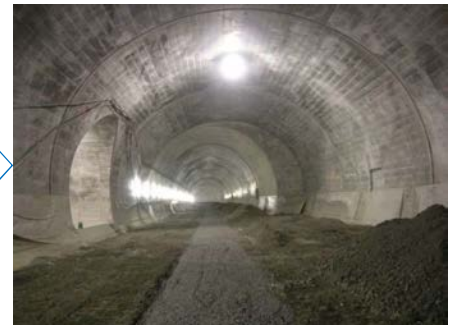
路盤排水工設置完了
