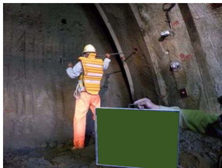
打設（ロックボルト）
