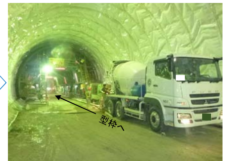
覆工コンクリート(ミキサー車)
