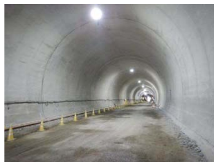
トンネル工完成
