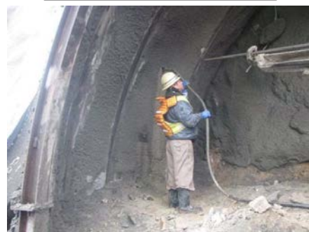
モルタル充填 (ロックボルト)
