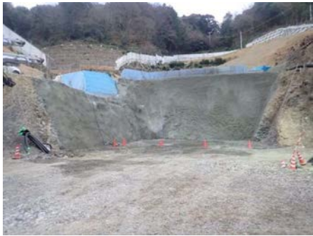
吹付コンクリート施工
