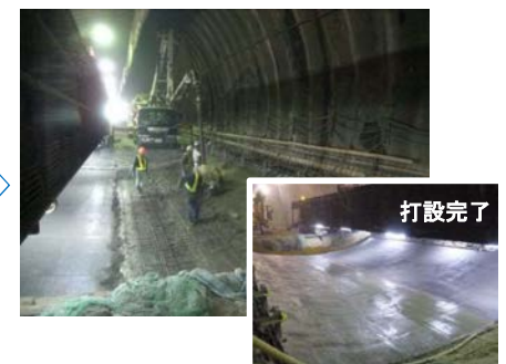
インバートコンクリート打設
