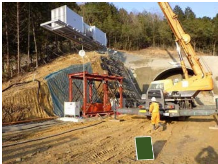
換気設備工（設置状況）
