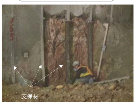
鋼アーチ支保工
