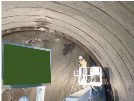
モルタル充填（フォアポーリング）
