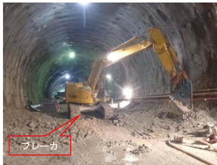
インバート掘削
