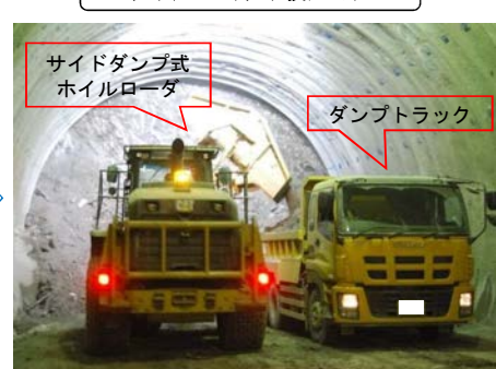
ずり処理（ずり積み）
