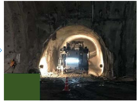
削孔 ( ロックボルト )
