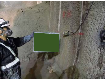
計測工B（ロックボルト軸力試験）
