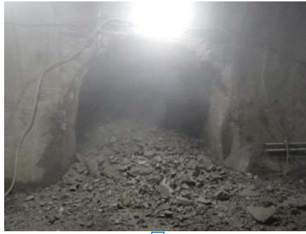
ずり処理 ( ずり積込み )
