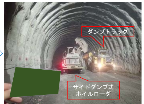
すり処理（すり積み・運搬）
