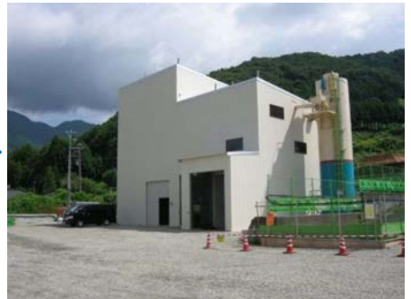
吹付設備工（設置完了）
