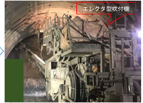
鋼アーチ支保工
