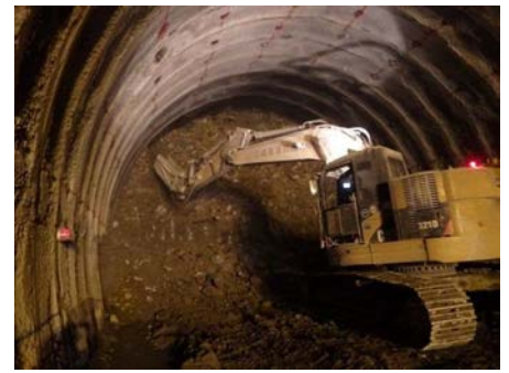
上半掘削 (油圧切削機)
