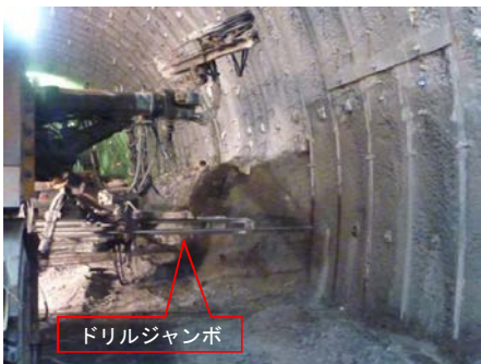
ロックボルト打設
