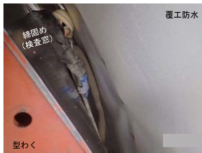
覆工コンクリート (打設)
