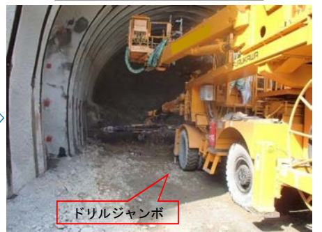
削孔 (ロックボルト)
