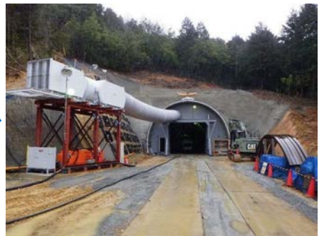
換気設備工（設置完了）
