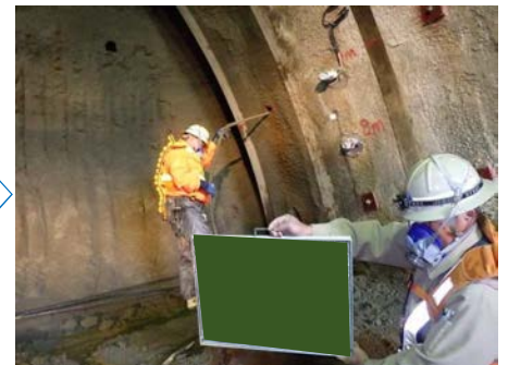
モルタル充填（ロックボルト）
