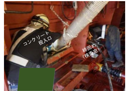
覆工コンクリート (打設)
