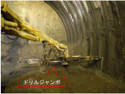
ロックボルト打設
