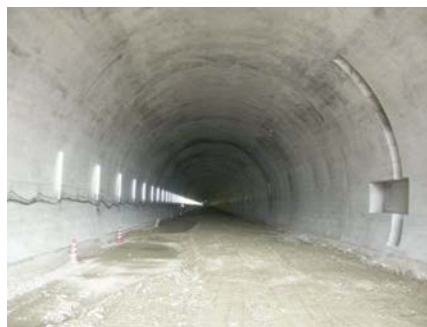
覆工コンクリート打設完了
