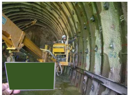
計測工B（地中変位測定）
