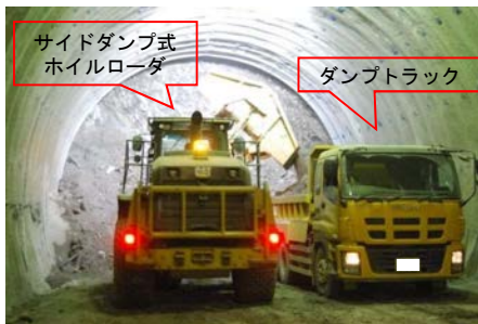
ずり処理 (ずり積み)
