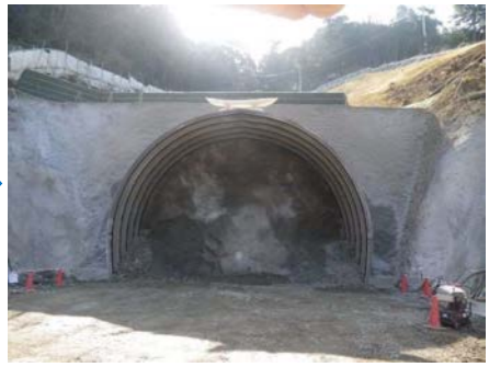
坑口切付施工完了
