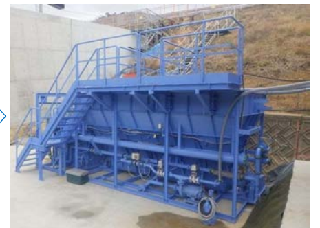
汚濁水処理工 (設置完了)
