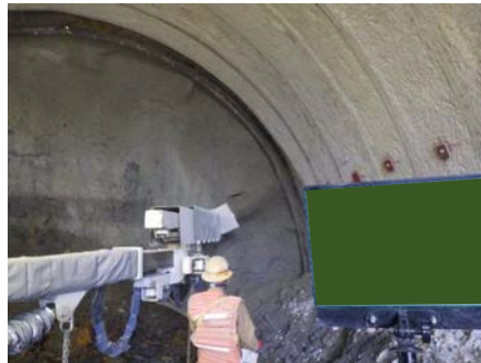
吹付コンクリート
