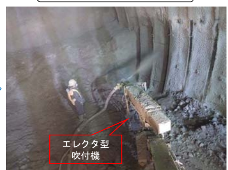
吹付コンクリート
