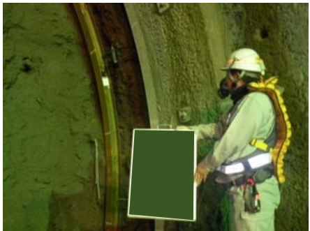
計測工B（覆工の応力測定）
