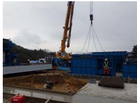
汚濁水処理工 (設置状況)
