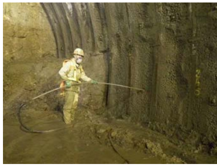
モルタル充填 (ロックボルト)
