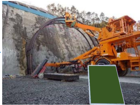
鋼アーチ支保工設置
