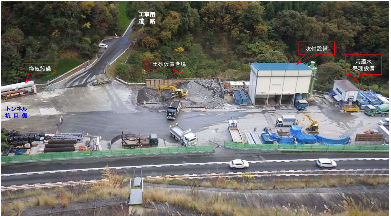
施工ヤード全景
