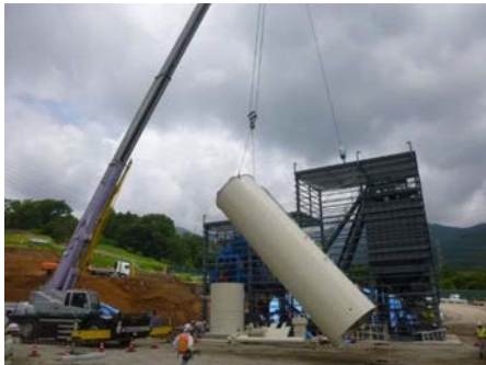
吹付設備工（搬入設置状況）
