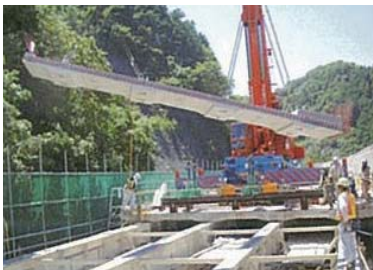
リニューアル工事(床版取替工事)状況
