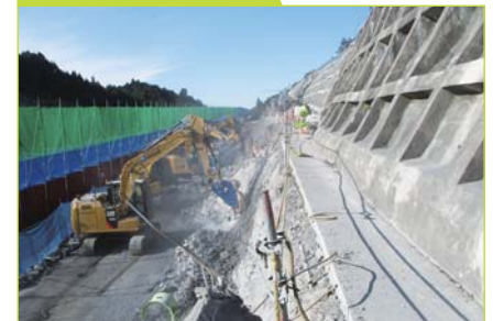
土工工事 拡幅箇所
