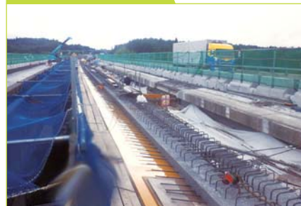
橋梁工事 拡幅箇所
